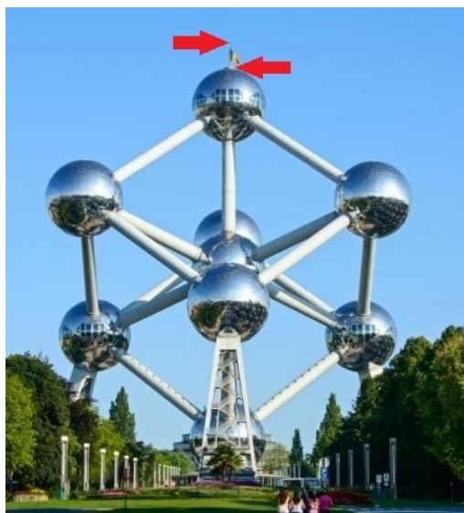
Afbeelding 21: Vlaggenmast boven op een monument
