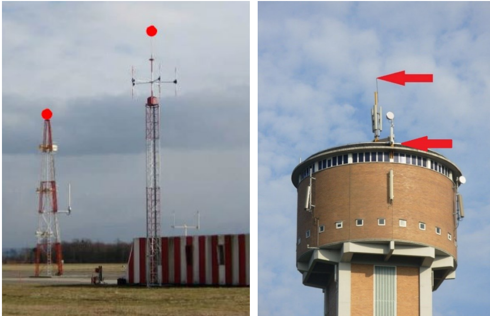
Afbeelding 5: Voorbeeld van antennes
