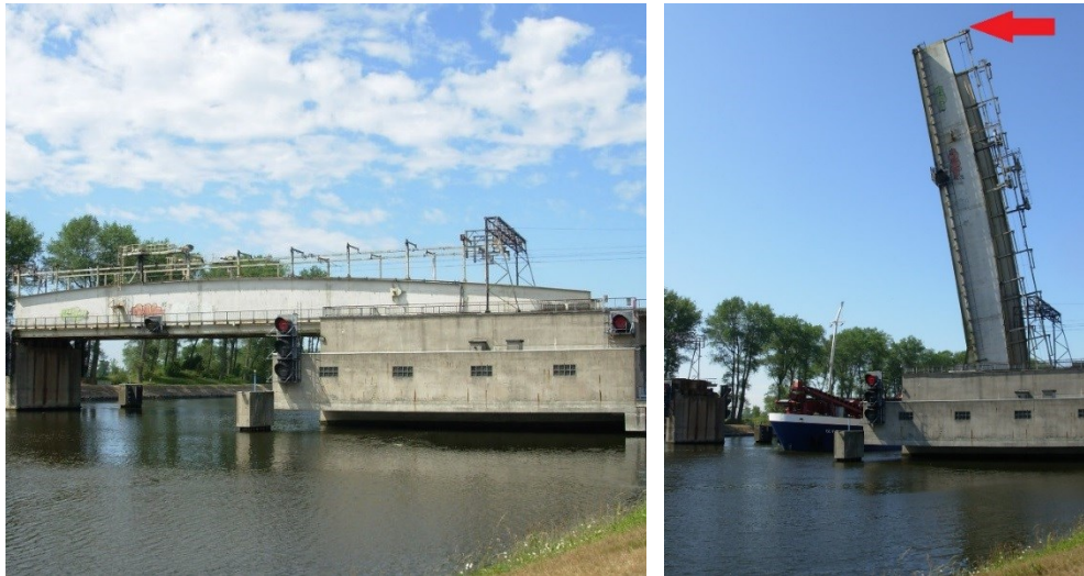
Afbeelding 7: Obstakelmeting voor een beweegbare brug
