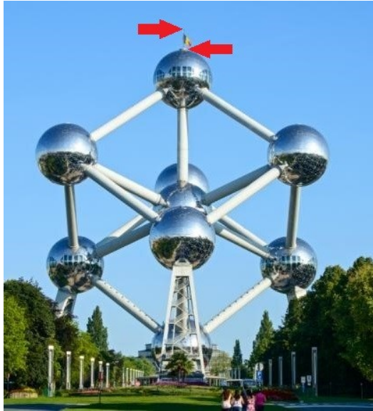
Afbeelding 17: Het Atomium is geregistreerd als een punt aangezien het gedeelte boven 60 m in een rechthoek met een breedte en lengte van minder dan 100 m past. De vlag bovenaan is een afzonderlijk obstakeldeel.
